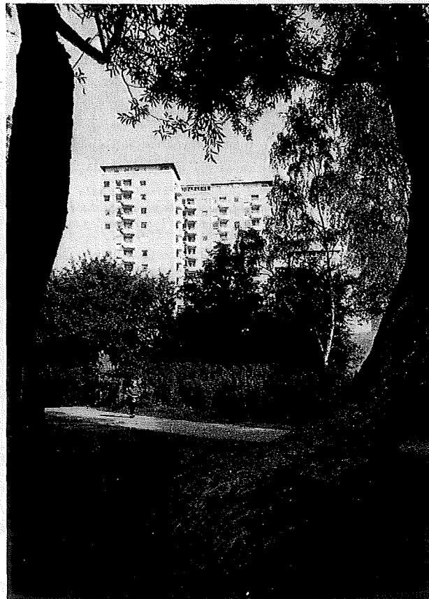
5. Bellahøj, højhusbebyggelse, AKB. Facademateriale af almindelig grå beton i ca. 20 x 70 cm fliser, 4 pr. etage. Altaner, bånd m. m. er af beton med en forstøbning udført af kalcineret flint og Faxemarmor.
